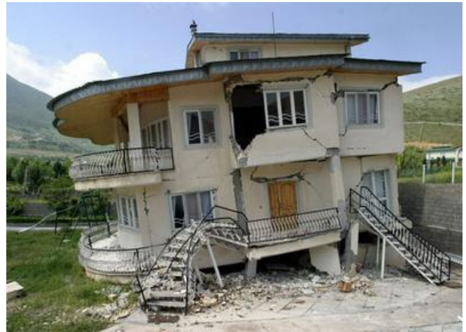
Durch ein Erdbeben zerstörtes Haus in der Provinz Gilan/Nordiran
